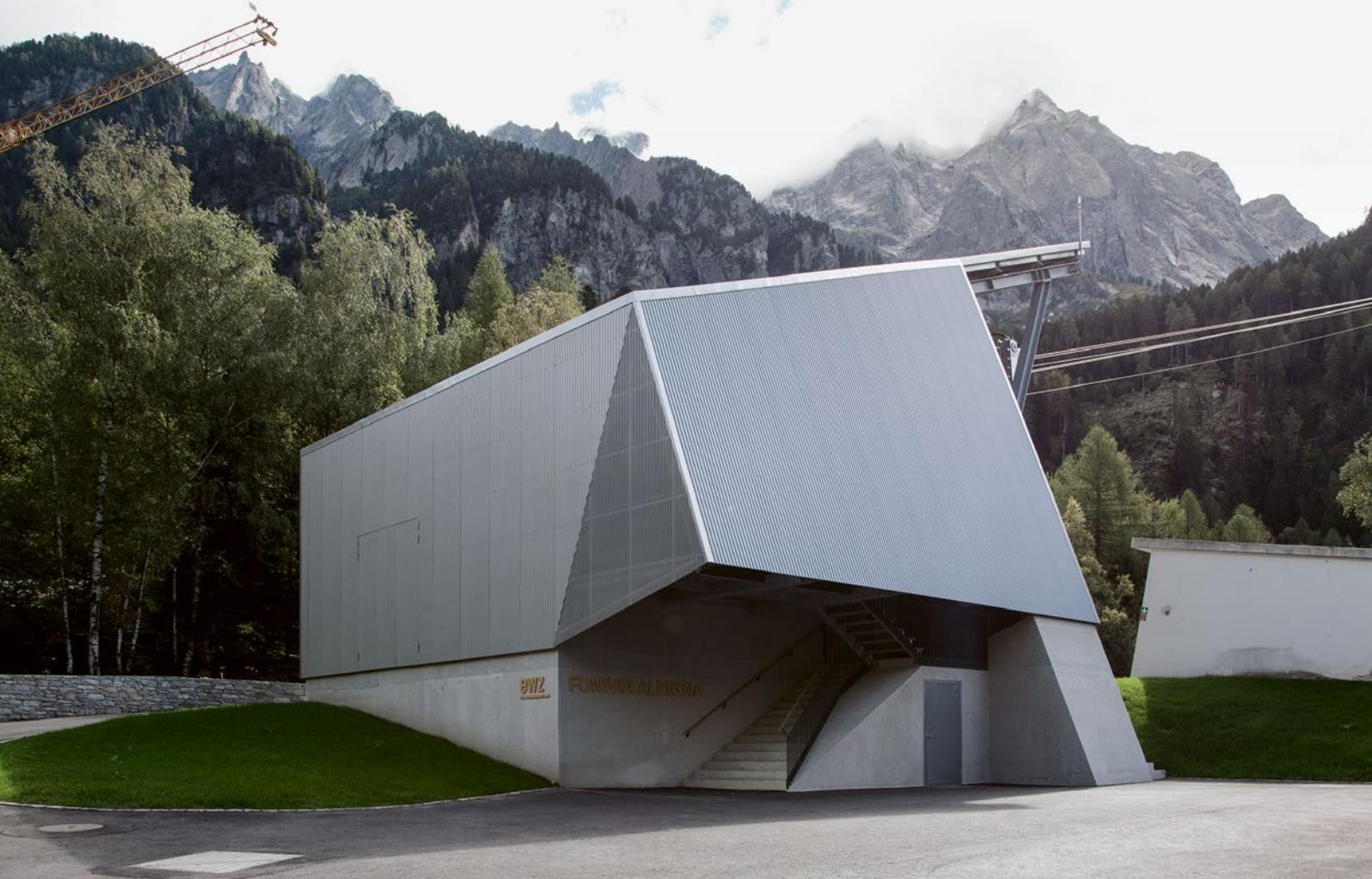
Stahlhaut auf einer Dreiecksfläche perforiert, um Licht in den Erschliessungsraum zu bringen. Von einer weiteren verglasten, bergseits angeordneten Aussparung in der Ummantelung können die Besucher einen Blick auf ihr Ziel werfen.
