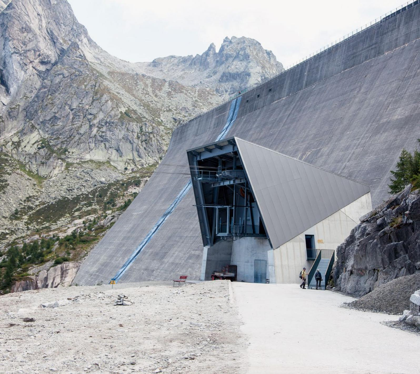
werden kann. Die beiden neuen Stationen sprechen die gleiche formale Architektursprache, unterscheiden sich jedoch in ihrer Ausformulierung voneinander. Beide bestehen aus einem Betonsockel, auf dem eine Stahlkonstruktion aufbaut. Der Stahlbau der Talstation erscheint dabei als leichter, gefalteter Überwurf; jener der Bergstation wirkt hingegen als steife Haube, der dem Sockel scharnierartig aufgesetzt ist.
