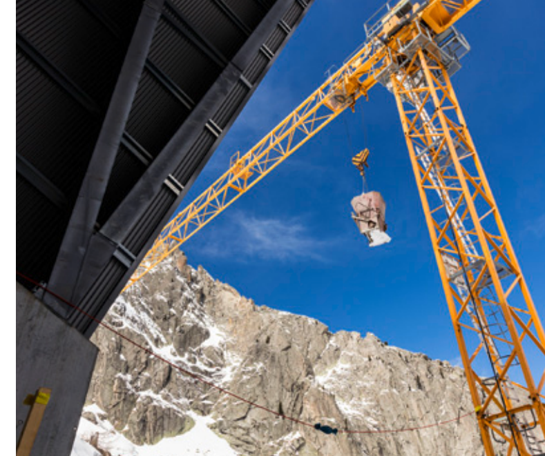
Gleichzeitig mit der Seilbahn wird auch an der Talstation gearbeitet.
