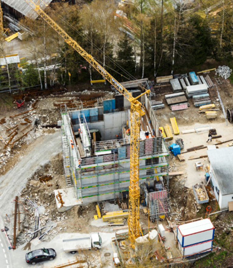
Wie die Berg- wurde auch die Talstation von Alder Clavuot Nunzi Architekten aus Soglio geplant.
