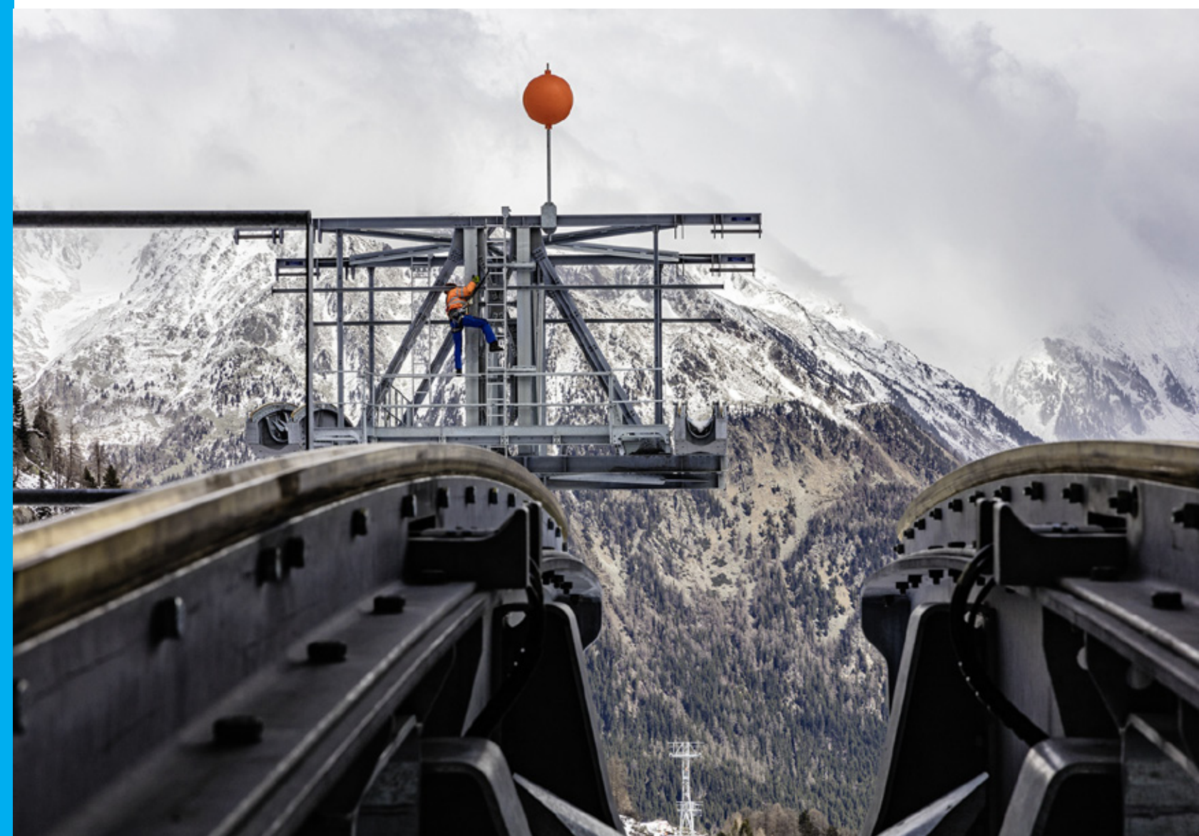
Die Sicherheit hat oberste Priorität beim Bau der neuen Seilbahn.
