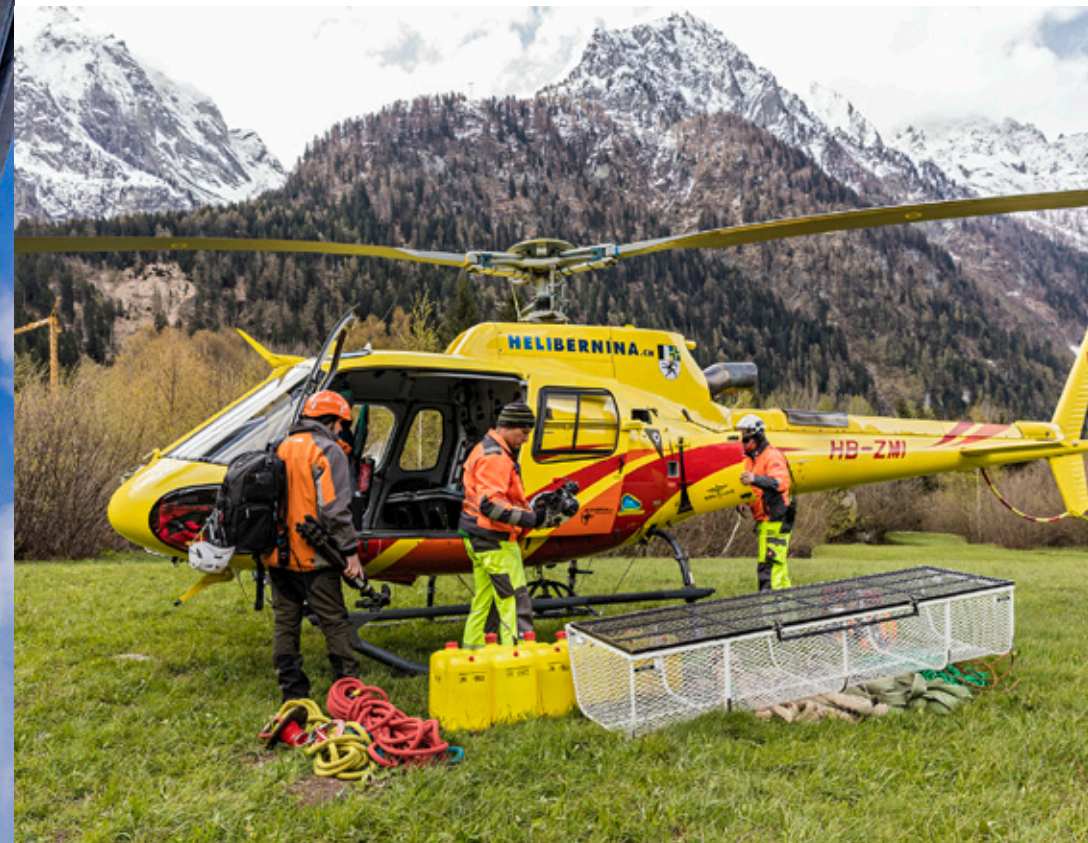
Material und Arbeiter werden vom Talboden her mit dem Helikopter auf die Baustellen am Berg gebracht.
