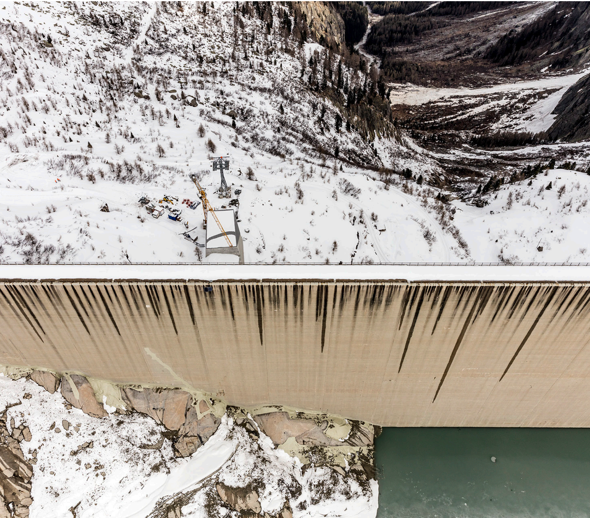
Selbst im Mai liegt auf den Baustellen und bei der Staumauer noch Schnee.
